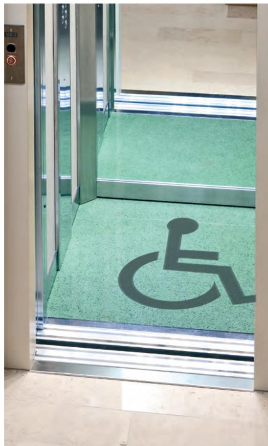
Sostituzione vecchie porte a battente con porte automatiche. Il vantaggio è di poter sfruttare l'intera luce netta dell'ingresso e garantire l'accessibilità dell'impianto anche ai portatori di handicap secondo quanto stabilito anche dalla normativa di riferimento.
